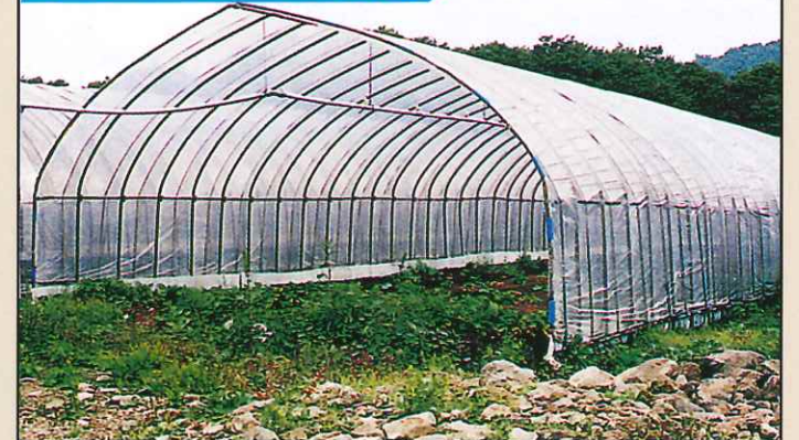
次のいずれかに該当する施設 1.主として屋根面のみがプラスチックフィルムにより被覆されている施設 2.その全体又は主として屋根面のみが通気性を有する被覆材(寒冷紗、ネット等)により被覆されている施設のうちプラスチックハウスⅦ類以外のもの
