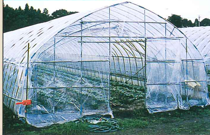
主としてプラスチックフィルムが被覆材として使用され、かつ、骨格の主要部分がパイプにより造られている施設
