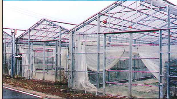
プラスチックハウスⅣ類甲 主としてプラスチックフィルムが被覆材として使用され、かつ、骨格の主要部分が断面係数1.31㎡以上の鋼材又はアルミ材により造られている施設のうち、プラスチックハウスⅣ類乙(鉄骨中・硬)及びプラスチックハウスⅤ類(鉄骨上)以外のもの
