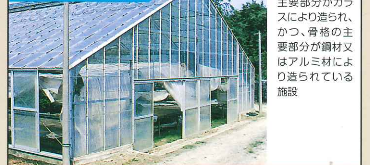
その全体が通気性を有する被覆材により被覆され、かつ、骨格の主要部分(隅柱、周田柱及び中つり柱)が鋼材、アルミ材又はコンクリートにより造られており、鋼線により接続されている施設
